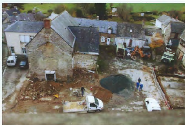
Réfection du réseau eau potable place de l'église, réalisée par le SIAEP de l'Orthe et de la Vaudelle
