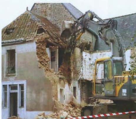
Démolition maison place de l'église
